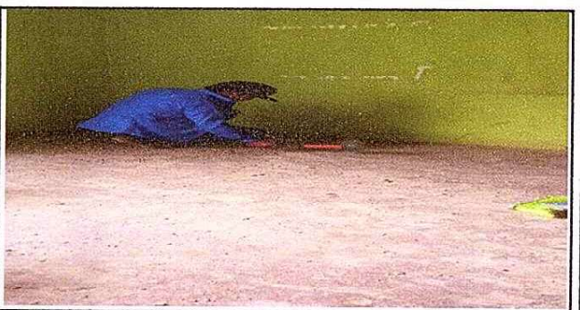
foto 6. inicio de la colocacion de piso ceramico.
