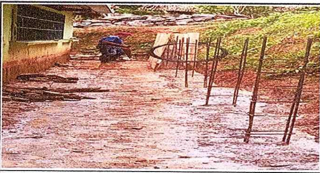
foto 5. fundicion de bases para el muro perimetral
