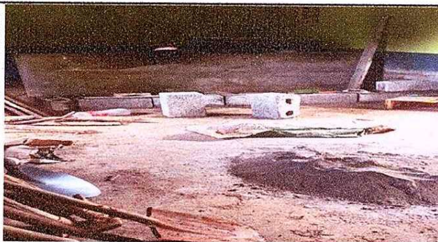
foto 3. construccion del polleton en la cocina
