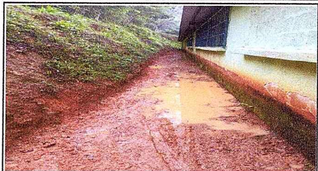
foto 2. lugar del muro perimetral, limpieza del area
