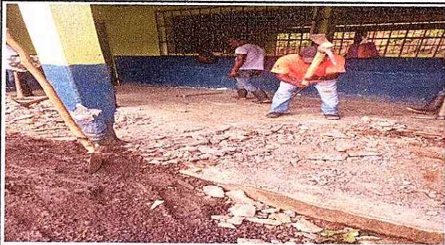
foto 1. inicio del trabajo de entortado del corredor del establecimiento.
